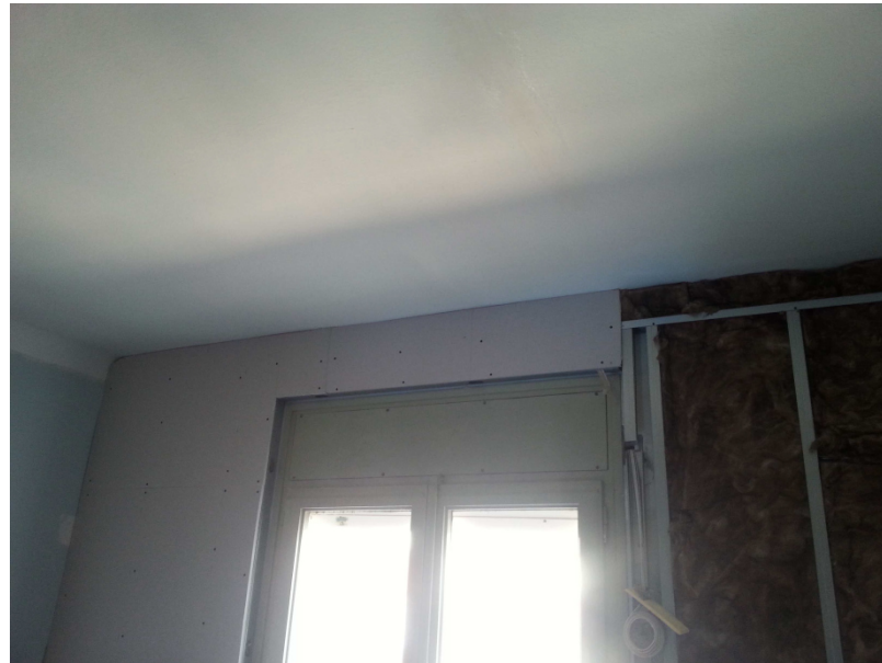
Realització de l'extradossat
