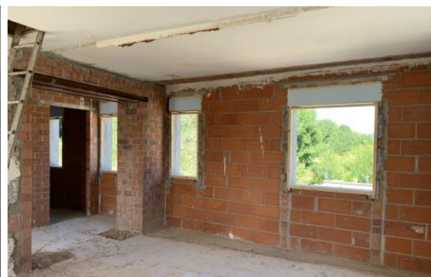
Obres de rehabilitació de l'interior
