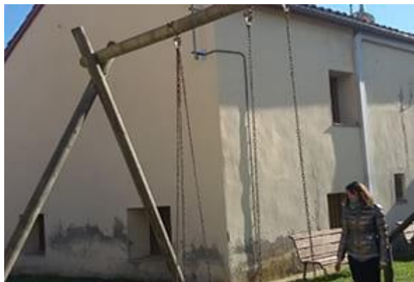
Edificació preexistent de l'antic Ajuntament de Sora
