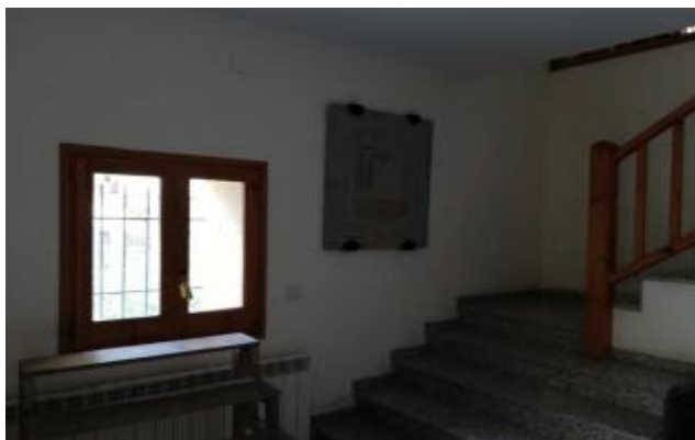
Imatge anterior a la intervenció d'adequació de l'interior
