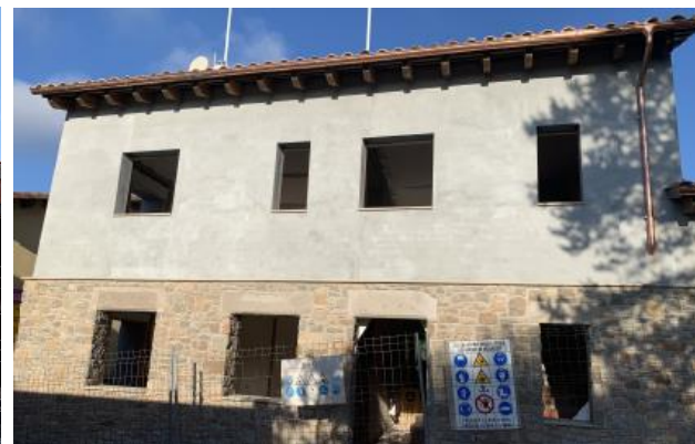
Façana principal després de la intervenció
