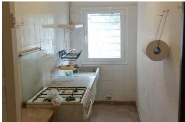
Imatge anterior a la intervenció de rehabilitació
