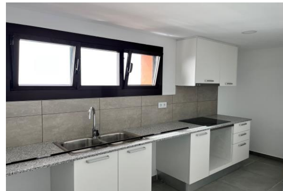
DESPRÉS DE LA INTERVENCIÓ DE REHABILITACIÓ
