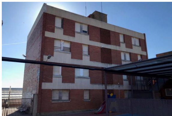
ABANS DE LA INTERVENCIÓ DE REHABILITACIÓ
