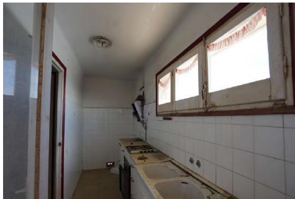
ABANS DE LA INTERVENCIÓ DE REHABILITACIÓ
