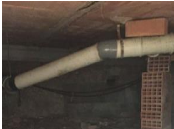
Imatge de l'estat de l'edifici. Estructura de fonamentació amb bigues de fusta
