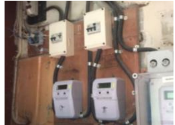
Imatge de l'estat de l'edifici. Instal·lació elèctrica. No disposa d'instal·lació de gas
