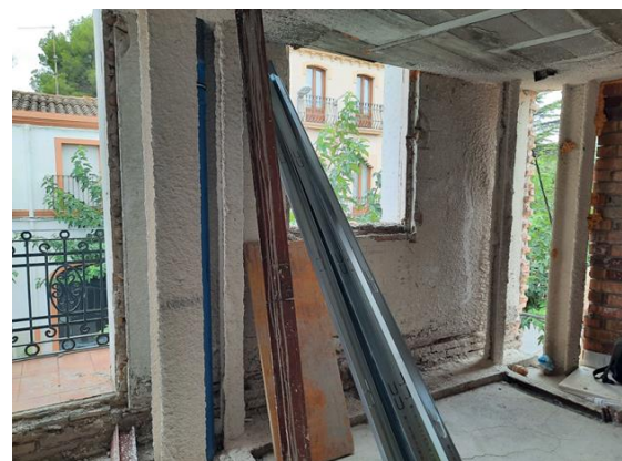
Imatges durant l'execució de l'obra. Aixecament d'una tercera planta-coberta respecte a l'edificació preexistent
