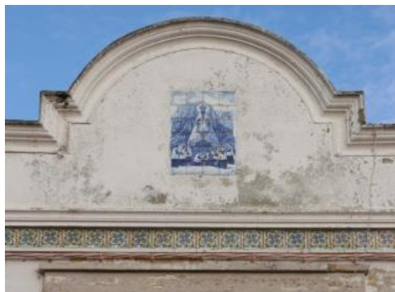
Imatge de l'estat de l'edifici. Detall façana principal
