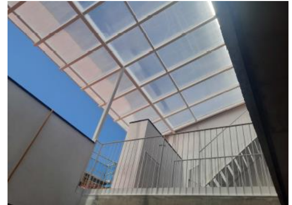
Imatge de la intervenció de gran rehabilitació finalitzada. Pati de llums interior
