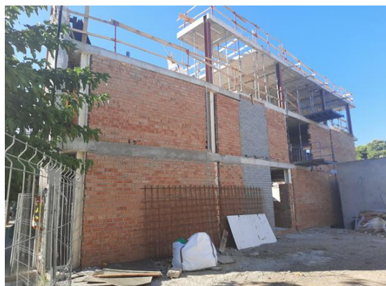
Imatges durant l'execució de l'obra. Aixecament d'una tercera planta-coberta respecte a l'edificació preexistent
