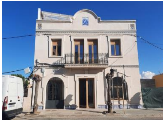
Imatge de la intervenció de gran rehabilitació finalitzada. Façana principal
