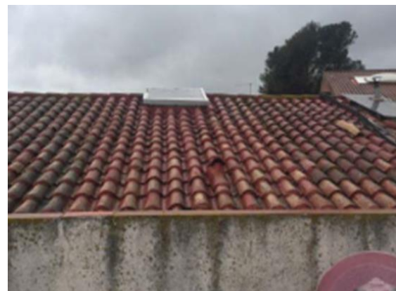
Imatge de l'estat de l'edifici. Coberta inclinada a dues aigües
