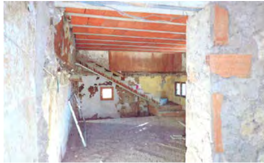
Imatges anteriors a les intervencions
