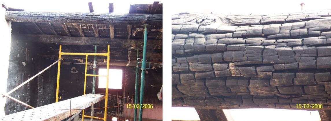
**Figura 1.-** Imágenes de estructura de madera afectada por el fuego
