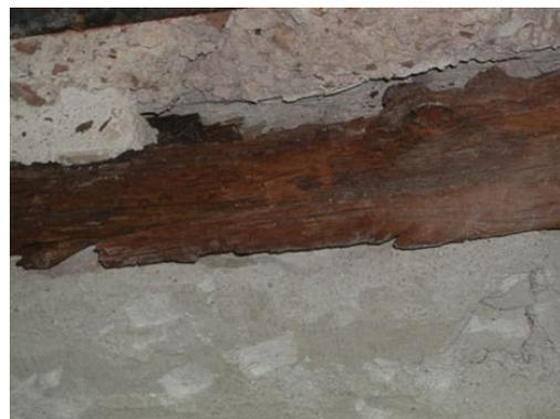
**Figura 13.-** Imágenes de madera afectada por pudrición parda
