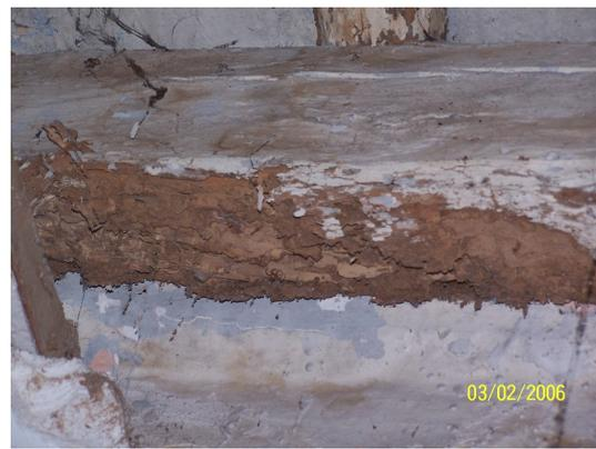
**Figura 6.-** Imágenes de construcciones termíticas del tipo “nido de resistencia”
