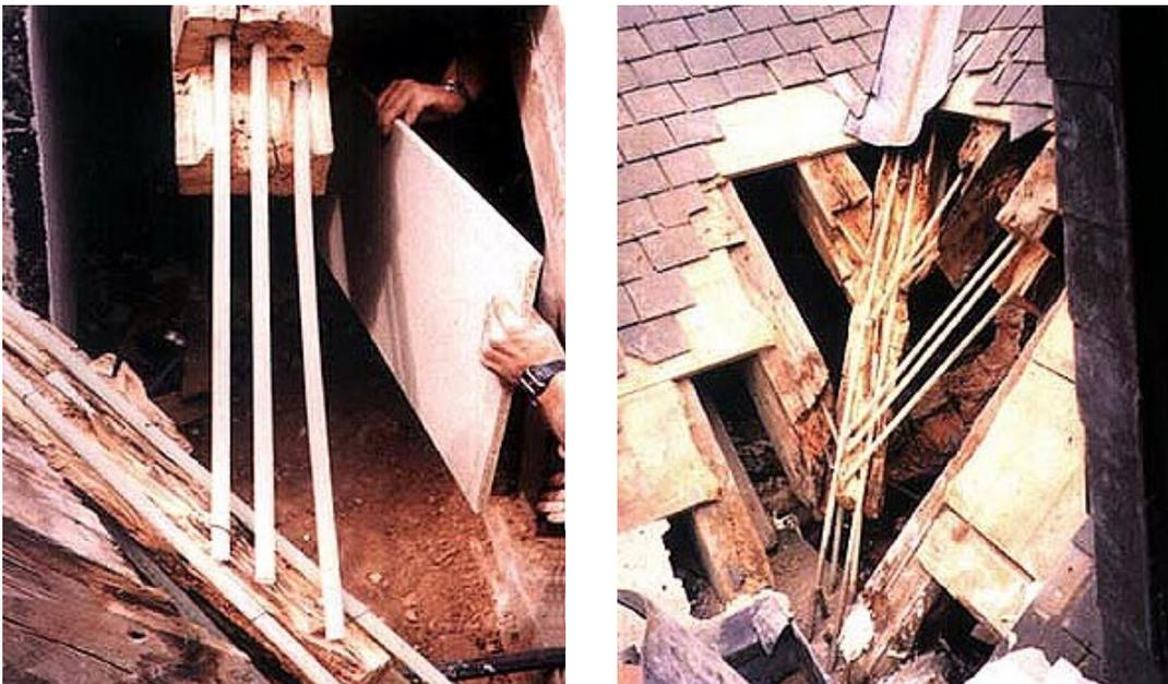
**Figura 16.-** Imágenes de refuerzo de vigas de madera con el sistema Beta
