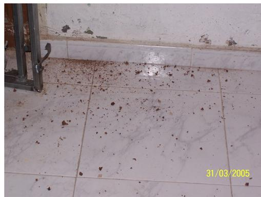
**Figura 7.-** Imágenes de restos de material en el suelo, que indican que se ha producido ataque de termita subterránea en la estructura de madera
